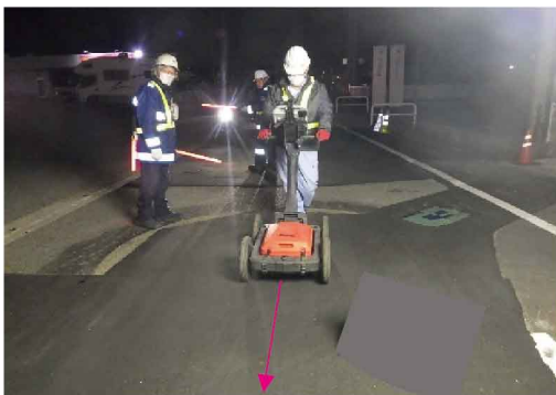
施工後の探査状況（発進立坑側）
