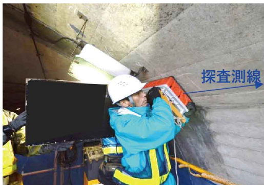
探查状況（離隔2m左側）
