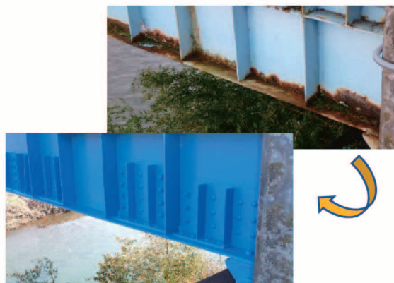
橋梁補修（当て板補強）
