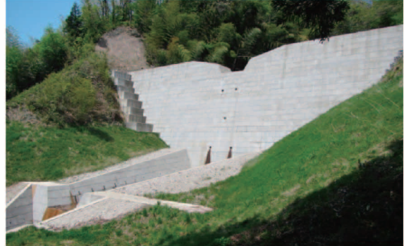
土石流対策（砂防堰堤）
