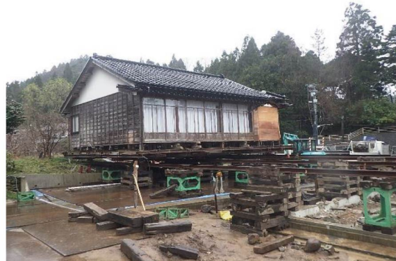
曳家移転工事
