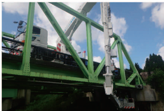
橋梁点検（橋梁点検車）
