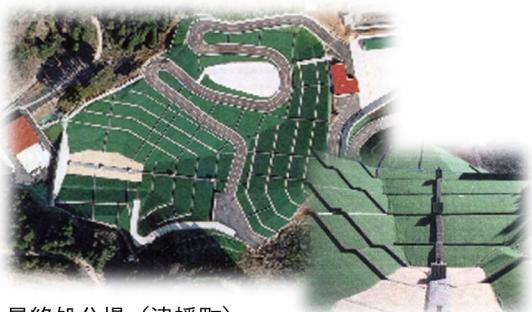
最終処分場（津幡町）
