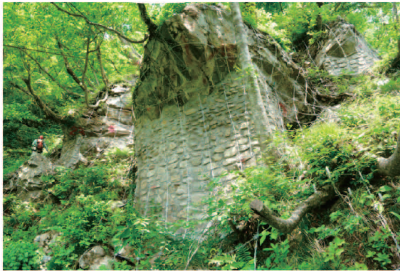
落石対策（ロープ掛、根固）
