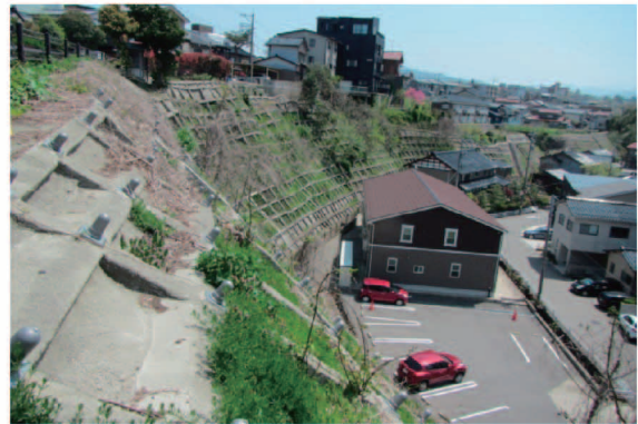
急傾斜地崩壊対策
