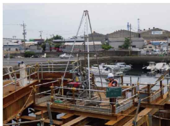
ボーリング調査
